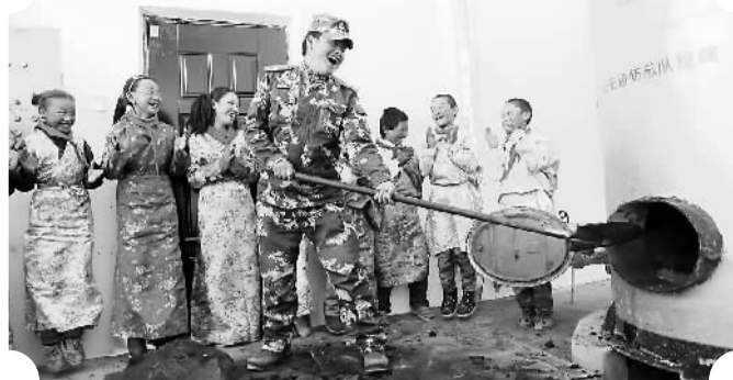
由西藏公安边防总队援建的日喀则市定日县岗嘎小学“暖冬工程”日前正式投入使用,看到边防警官往锅炉里加煤,小学生们十分高兴,这个冬天不再寒冷了。
