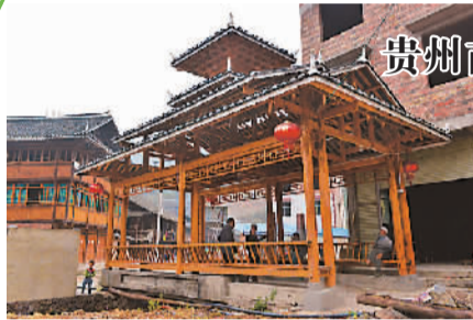
贵州省榕江县所修建的候车亭均由县交通局统一设计,并统一安排木工巧匠施工,使设计与修建保持一致。候车亭的设计为三排立柱长形空间,下围长廊式美人靠椅,中部为四周花格连接,上为五层重檐龙凤翘角,中排项上为元宝柱,民族特色浓郁。目前,该县已经投入500余万元,在78个村寨共修建150个候车亭,使当地苗乡侗寨18万群众受益。
