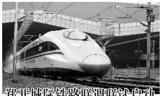
郑开城际铁路联调联试启动
