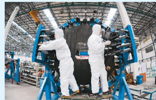
图为10月30日,工程人员在厂区内进行C919后机身前段79框的施工。新华社记者 姚剑锋摄
