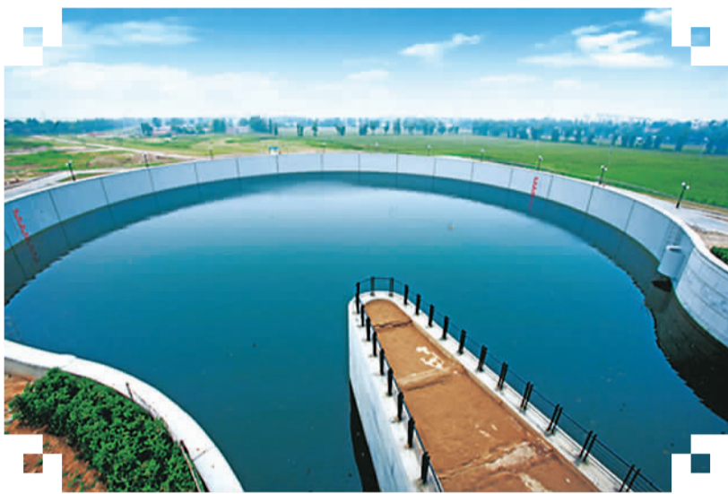
图为大宁调压池
