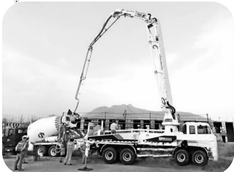
中联重科38米臂架泵车助力秘鲁VILLA MARINA别墅项目。
