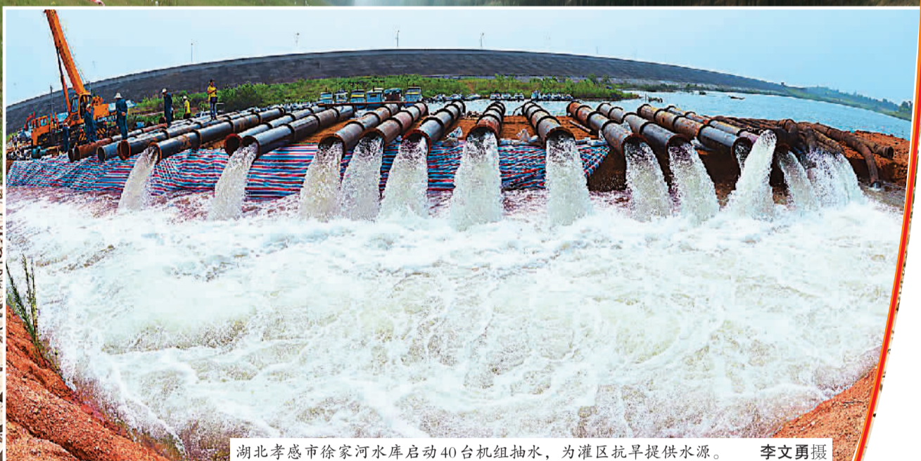
湖北孝感市徐家河水库启动40台机组抽水,为灌区抗旱提供水源。 李文勇摄
