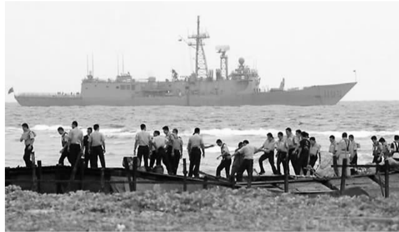
台湾在太平岛兴建码头现场。（图片来源：百度）
