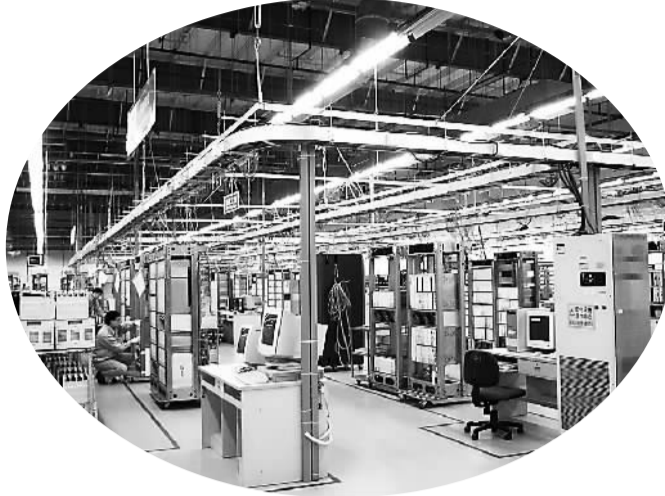
青岛朗讯科技通讯设备有限公司机柜测试车间
