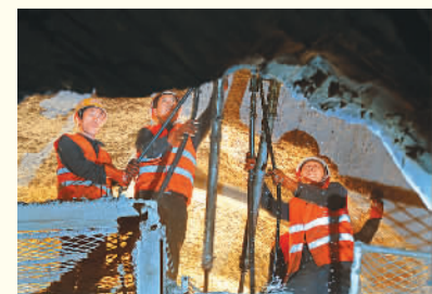
图为4月15日,中铁隧道工人在进行最后的掘进施工。 本报记者 雷声摄
