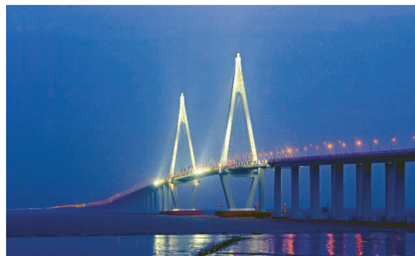
杭州湾跨海大桥
