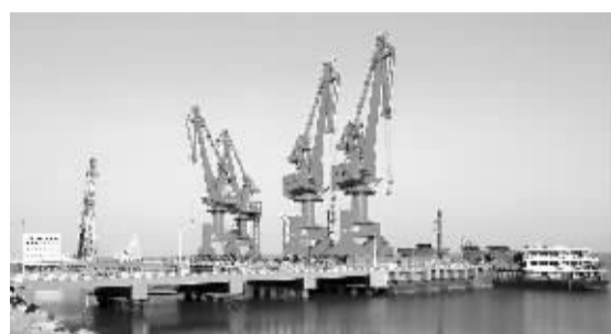
徐圩港区建设现场。
