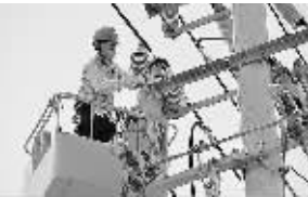
平湖市供电公司检修人员在修补绝缘损坏的开关引线。 林洁摄
