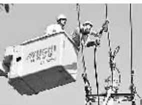
在桐乡市经济开发区，供电公司采用不停电作业法，对线路进行了检修。 冷丽华摄
