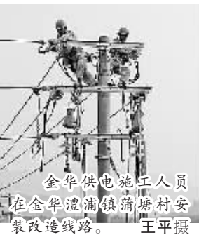
金华供电施工人员，在金华澧浦镇蒲塘村安装改造线路。 王平摄
