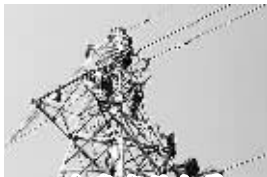
永康市供电员工正在安装导线附件。 陈方正摄
