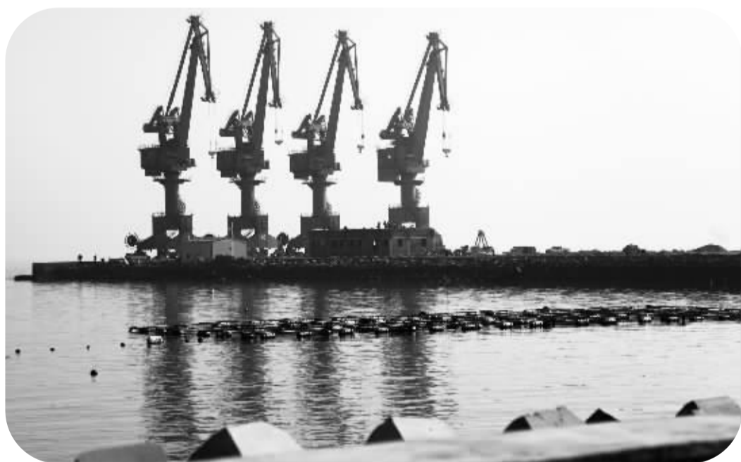
张家埠新港是山东省威海市为承接韩日产业转移，迎接中日韩自贸区新机遇，优化港口布局而建设的一期工程包括5公里引堤和2个万吨级杂货泊位，设计年通过能力107万吨，总投资6.25亿元，目前主体工程已经完工，预计2014年2月投入运营。近期获批的港口二期——5万吨级泊位工程，将于明年开工建设。图为建设中的张家埠新港。 陈宏青摄（中新社发）
