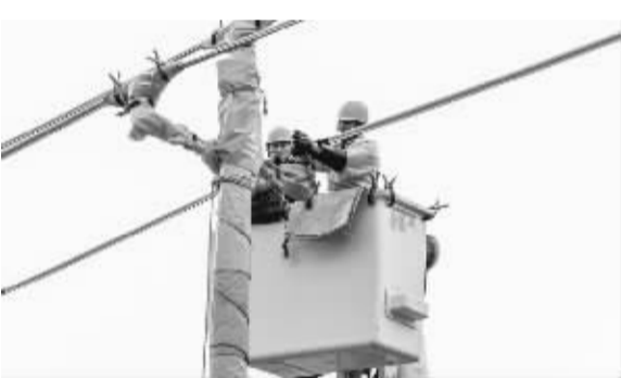
温岭供电公司带电作业班进行带电接电缆终端引线作业演示。
