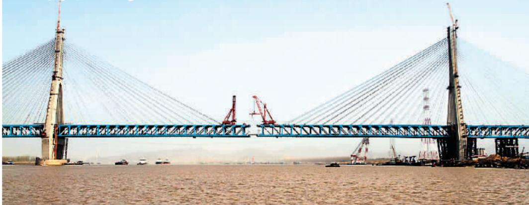
正在建设中的安徽铜陵长江公铁大桥,预计12月16日大桥合龙贯通。铜陵长江公铁大桥是合福(合肥至福州)高铁安徽段关键性工程,上方为双向六车道高速公路,下方为四条铁路复线。大桥主桥长1290米,其中630米主跨创同类型桥梁世界之最。
