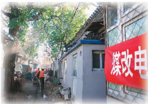
工人在北京东城区清华街进行“煤改电”施工。新华社记者 罗晓光摄
