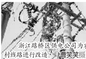
浙江路桥区供电公司农村线路进行改造。曹笑笑摄
