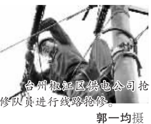
台州椒江区供电公司抢修队员进行线路检修。郭一均摄
