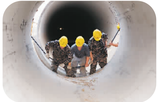
9月30日,在南水北调工程配套工程河北省邢清干渠,工人在铺设输水管道。
