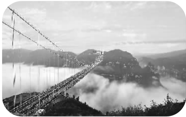
湘西矮寨大桥 向民航航摄
