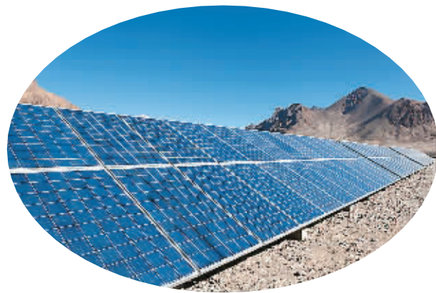
由国家和中国国电龙源西藏新能源有限公司共同投资建设的海拔最高的10兆瓦级光伏电站——阿里光伏电站,于今年1月并网发电。
