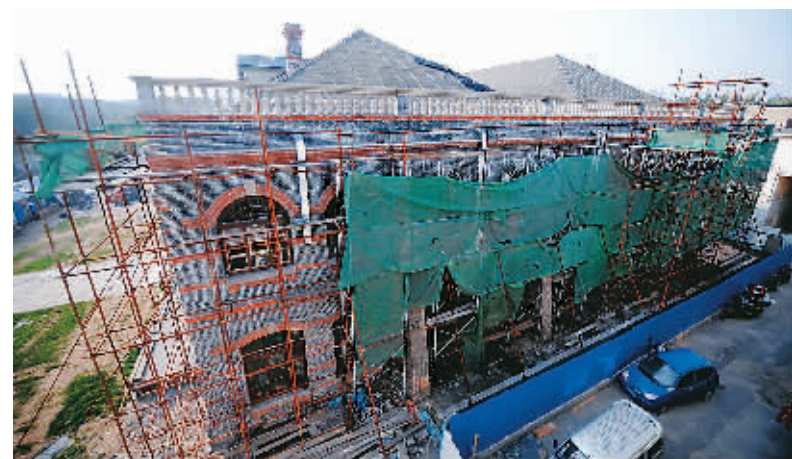
位于沈阳的东三省总督府旧址建于清朝末年,日前开始进行最大规模的修缮。目前,总督府旧址室内的抢救性修缮已经完成,室内复原施工还没有进行,全部修缮复原还需要3至4年。张文魁摄(新华社发)
