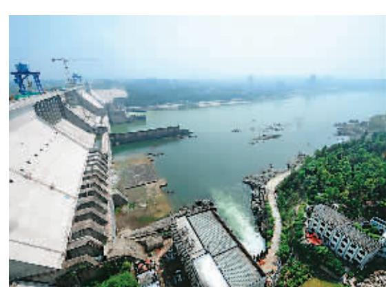
8月26日,南水北调中线丹江口大坝加高工程开始接受蓄水验收。验收专家组将进行为期3天的技术初步验收,确认加高后的丹江口大坝是否满足今秋汛后蓄水的要求。丹江口大坝加高工程2005年开工,目前坝顶高程已由原来的162米加高至176.6米。蓄水后,丹江口水库正常蓄水位将从157米提高至170米。图为加高加宽工程已经完工的丹江口大坝。
