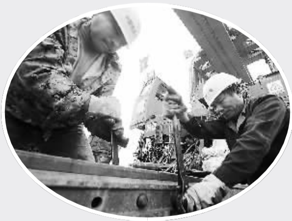
▲铺架人员在特大桥上铺设轨排
