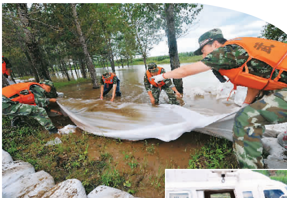
▲在黑龙江堤防避免干岔子段，武警黑河支队的官兵在排险固堤。新华社记者 王建威摄
