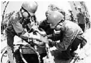
8月8日,宁波供电公司20多名员工经过6小时的努力,对附近一条10千伏电缆进行开口,并通过新接电缆将电成功送入了泽明小区。
