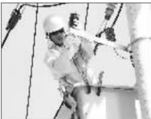
国网永康市供电公司带电作业班吴鹏武在10千伏供电线路上安装新的避雷器。徐芝婷摄
