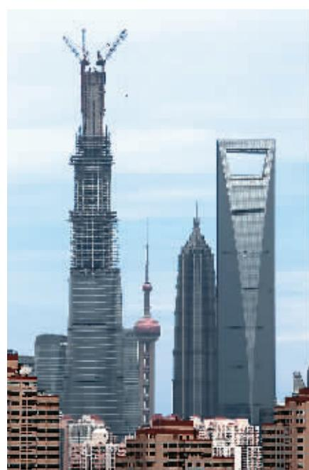
8月3日上午，随着最后一根钢梁吊装就位，“上海中心”实现主体结构封顶，达到125层、580米的高度，至此，“上海中心”经过近5年科学组织的建设任务，顺利完成了阶段性的建设目标。按计划，到2015年，“上海中心”将成为小陆家嘴地区最后一幢完工的超高层建筑，以632米刷新上海的新高度。
