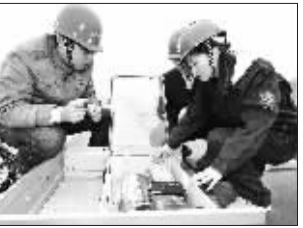
国网杭州电力公司专业人员上门为光伏企业提供技术指导支持。钱英摄
