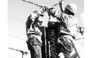
7月9日，舟山供电公司状态检修组圆满完成110千伏双屿变110千伏I段所有刀闸检修，排除刀闸发热隐患。张雄清、李钰洪 摄
