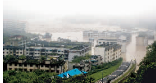
8日至9日凌晨4时，四川省北川羌族自治县境内持续暴雨，北川老县城“5·12”地震遗址全部被淹，最深处超过7米。图为被暴雨袭击的老县城。 王关伦摄（新华社发）
