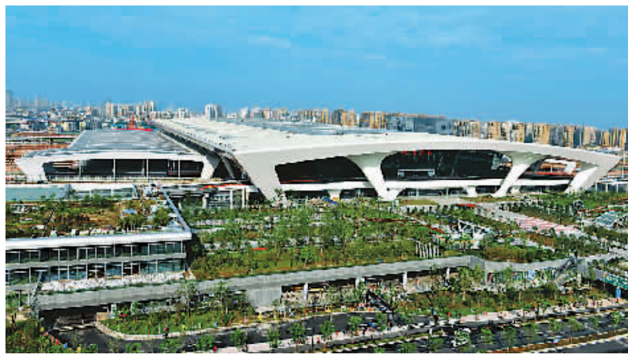
图为中国最大铁路枢纽——杭州东站外景。
