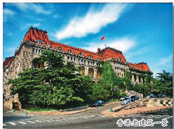
香港老建筑一景
