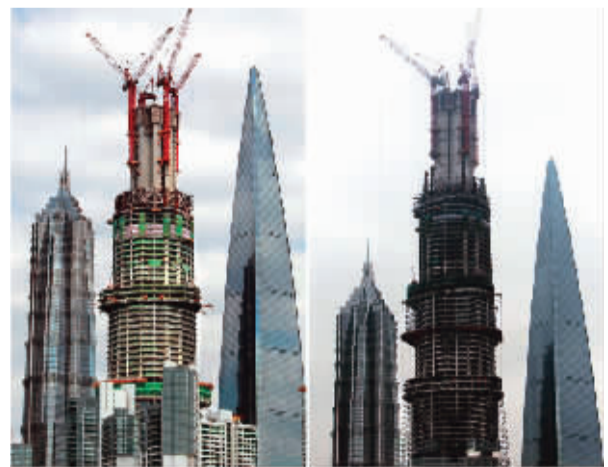
目前，设计高度为632米、121层的上海中心大厦主楼核心筒（中）已施工至101层，高度攀升至470米。建设中的上海中心大厦不断长高，现已超越金茂大厦和环球金融中心大厦。（左图：摄于去年10月11日，右图：摄于今年3月13日）新华社记者 裴鑫摄
