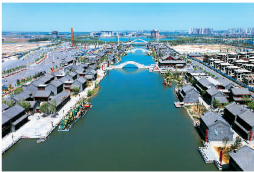
唐山市丰南区津唐运河景观建成实景
