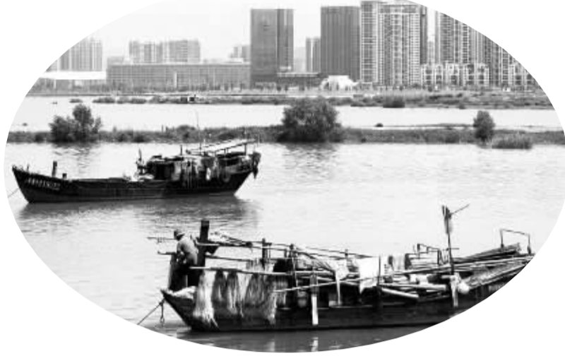
深圳前海，昔日的滩涂渔村，如今填海工程基本结束，未来，这里将成为人民币国际化的出口。
