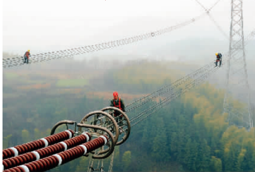
皖电东送1000千伏淮南—上海特高压交流输电示范工程淮河大跨越工程日前完成放线施工,成功跨越淮河。特高压电网像一条条纵横云天的能源大动脉,为经济发展提供源源不断的动力。图为工作人员在对向家坝—上海±800千伏特高压直流输电线路检修。(新华社发)
