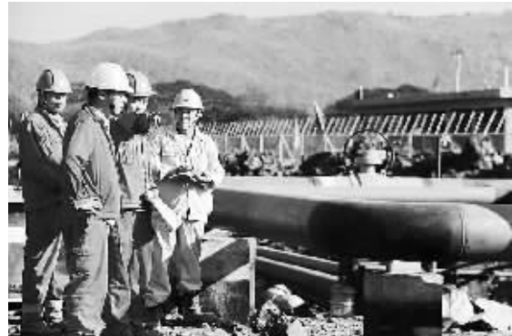
图为曼德勒天然气分输站施工现场。
