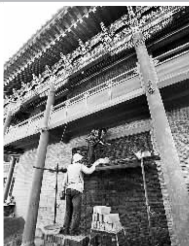
山西将在一年左右投入七千万“保养”五台山十四座重点寺庙。图为工人在修缮五台山景区一处建筑。詹彦摄
