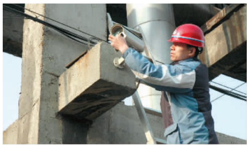
楚源集团员工正在维修环保监控设施
