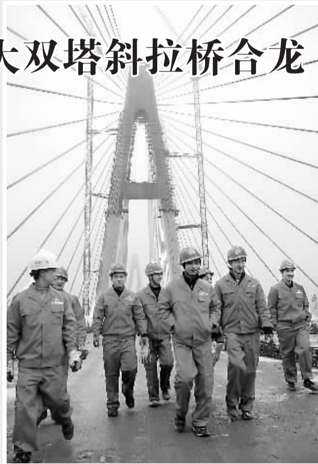
右图:建设者在桥上。
