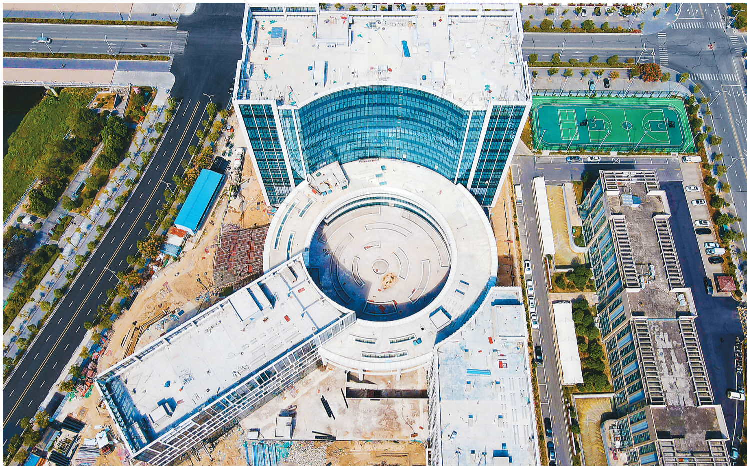
图为安徽省安庆市岳西县大数据产业园项目建设现场。
