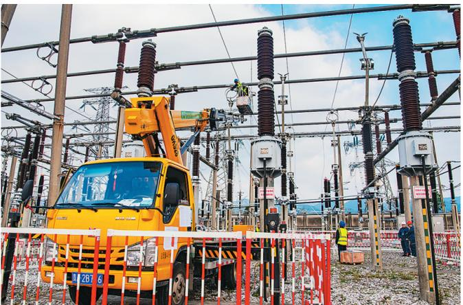
今年以来，南方电网在贵州贵阳加速实施大规模供电设施更新改造，为当地平稳用电提供保障。图为日前在贵阳市息烽县500千伏息烽变电站，南方电网工作人员正在进行主变升级更新。
