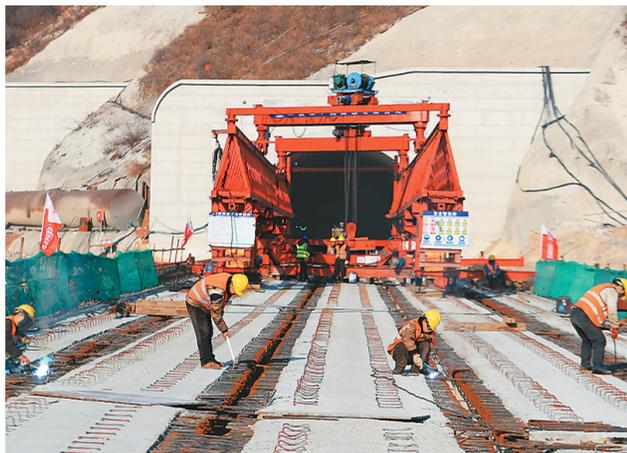
日前，由中国铁建投资集团投资建设、中铁二十局承建的凌源高速公路4a标段最后一孔T梁架梁完成，至此该标段桥梁架梁全部完成。凌源高速公路建成后，将为辽宁省西部地区开辟一条新的出海通道，对改善辽宁西部地区及内蒙古东部地区交通状况，促进沿线地区资源开发和经济发展具有重要意义。图为建设者在桥梁上进行施工作业。新华社记者 杨青摄
