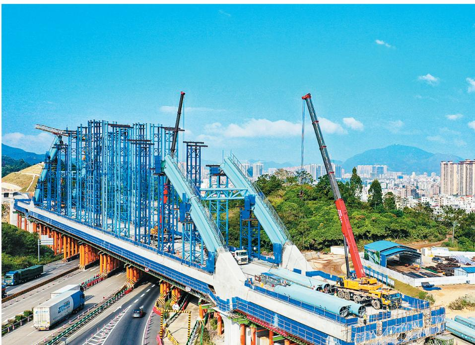
南（宁）深（圳）高铁是广西壮族自治区连接粤港澳大湾区的重要快速通道，项目建成后，桂粤港澳将更加紧密联结，不断推动经济社会高质量发展。图为日前，在位于广西岑溪市岑城镇思孟村的南深高铁跨包茂高速特大桥施工现场，塔吊、吊车等机械正在建设大桥的拱门。
