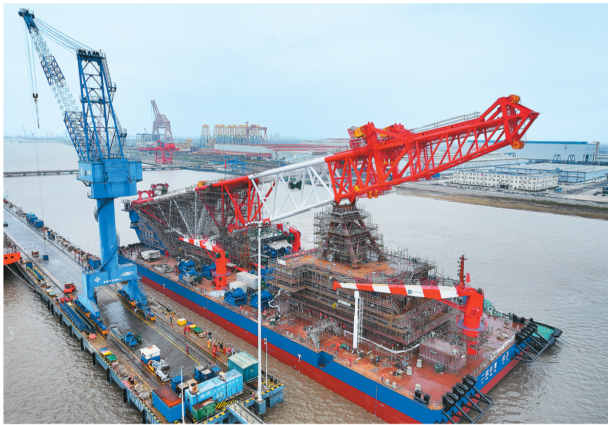
11月14日，上海振华重工为中交二航局建造的打桩船“二航长青”在江苏启东海工船舶工业园顺利出坞。超大型打桩船是跨海通道、深远海风电、海洋石油资源开发等重大工程建设的重要支撑。“二航长青”是目前世界上在建的最大打桩船，总长130.5米，可打最大桩重700吨、直径7米的桩基，同时实现深远海厘米级精度打桩。
