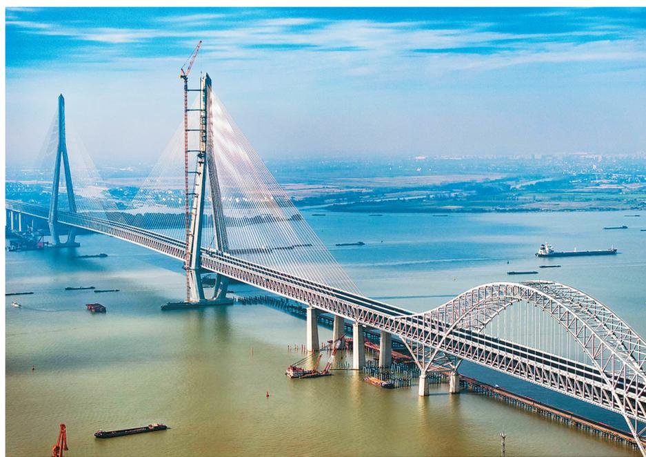
经过一段时间的紧张施工，常泰长江大桥上下层钢桥面主体结构全部完成。常泰长江大桥连接江苏省常州、泰州两市，是长江上首座集高速公路、城际铁路、普通公路三种方式于一体的过江通道，全长10.03公里，其中双层连续钢桁梁长度达到4266米。据了解，该桥预计将于明年上半年具备通车条件。通车后，泰州到常州的车程将从1个多小时缩短到20分钟。图为11月9日，常泰长江大桥施工现场。 汤德宏摄（人民视觉）
