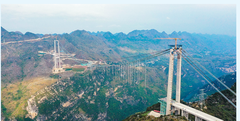
贵州六安高速花江峡谷大桥钢桁梁吊装现场。刘青摄（人民视觉）
