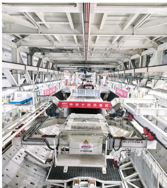
青岛胶州湾第二海底隧道施工现场。本报记者 张一琪摄
