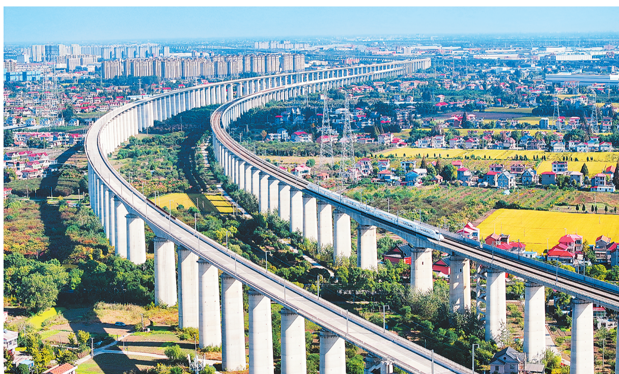
今年前10月,沪苏通铁路江苏南通西站到发旅客538万人次,南通站到发旅客667万人次。沪苏通铁路开通运营4年来,极大便利了沿线群众出行,缩短了上海与南通及苏北地区的时空距离,有力助推长三角一体化发展。
