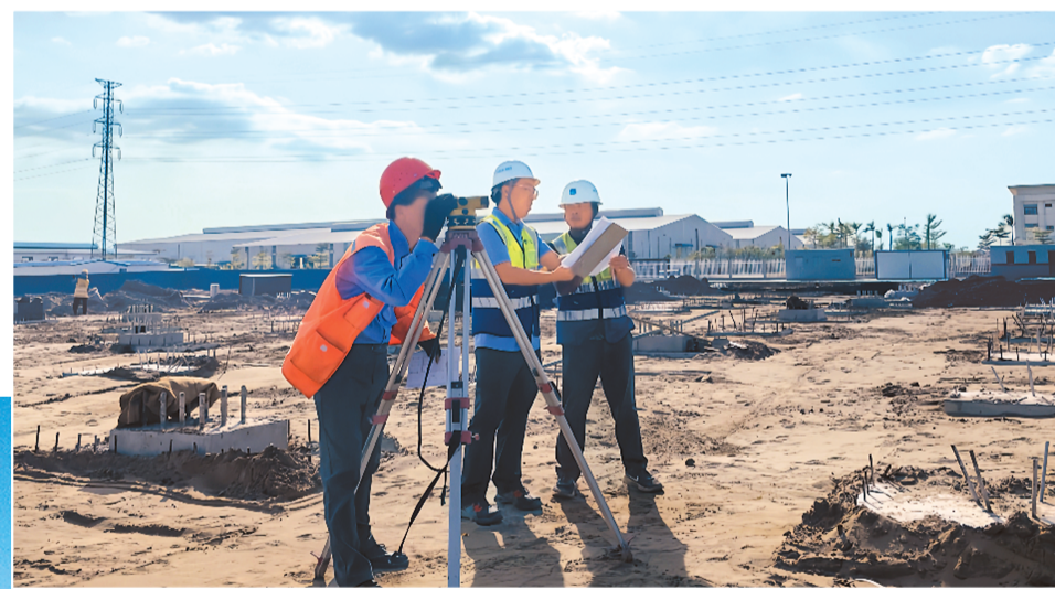
▼在越南巨星三期项目，中建五局技术员赵基尊（中）与同事对场地标高进行复核。 杨冀生摄
