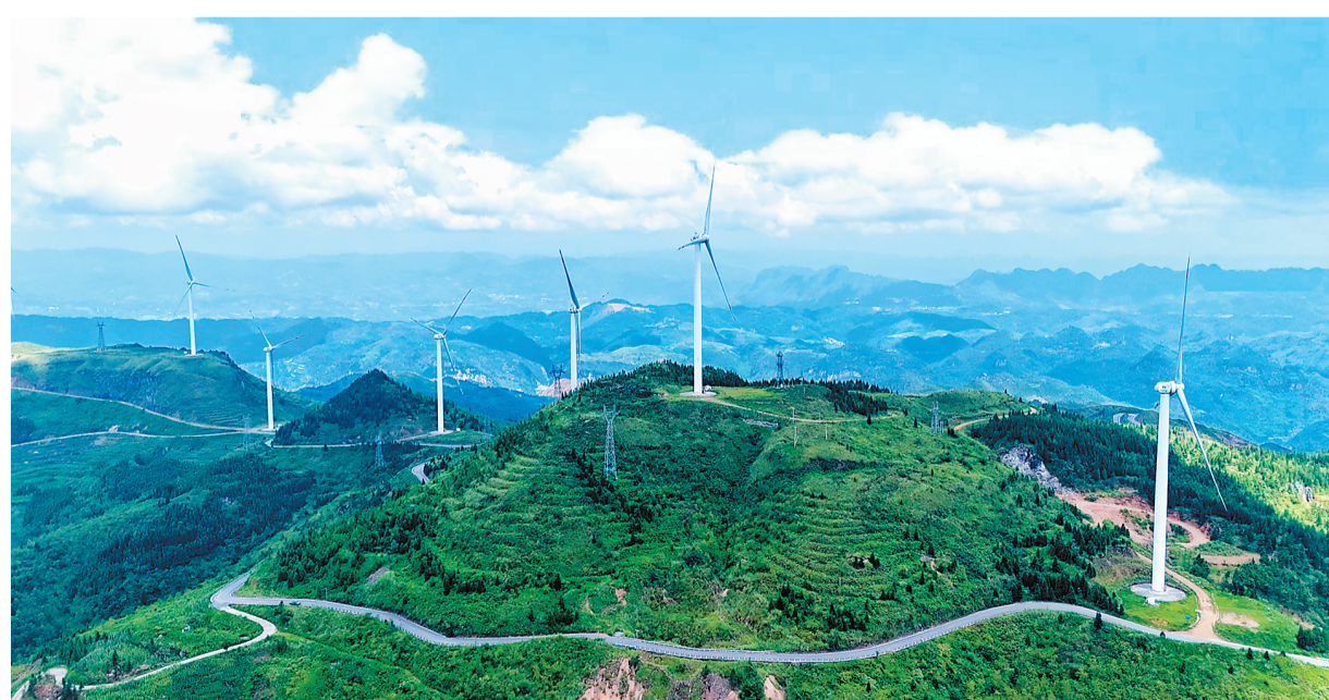
贵州省晴隆县近年来积极构建多元化能源体系，在大镇投资建设苏家屯风电场，该发电场总装机容量达42兆瓦，年发电量超8900万千瓦时。南方电网晴隆供电局积极服务当地绿色电能接入和消纳，助推能源绿色低碳转型。图为苏家屯风电场。肖 雄摄(人民视觉)
