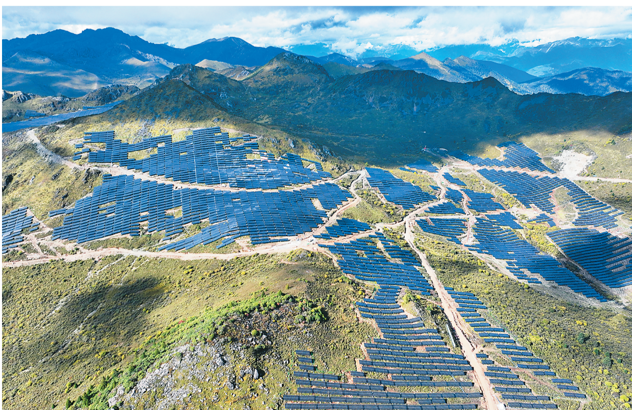
近日，位于四川省凉山彝族自治州木里藏族自治县的立洲水电站水光互补让白光伏项目全面并网发电。该项目未来年均发电量约1.78亿千瓦时，预计每年可节约煤炭5.4万吨，减少二氧化碳排放量14.7万吨。图为该项目的光伏面板在平均海拔4200米的山坡上整齐排列。
